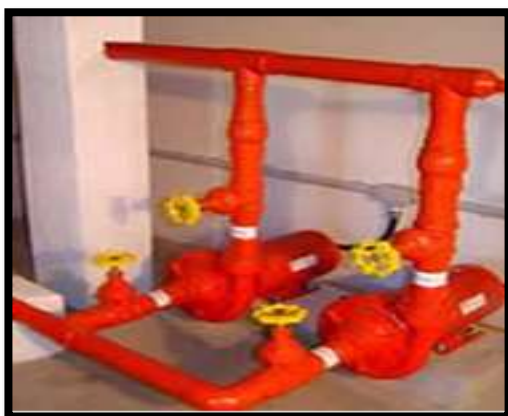
Figura 16 - Bomba de Incêndio
